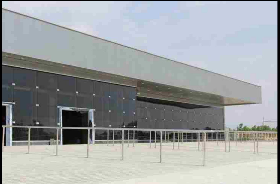
نمای کرتین‌وال حدود ۲۰۰۰ مترمربع و هندریل‌های شیشه‌ای و کابلی
